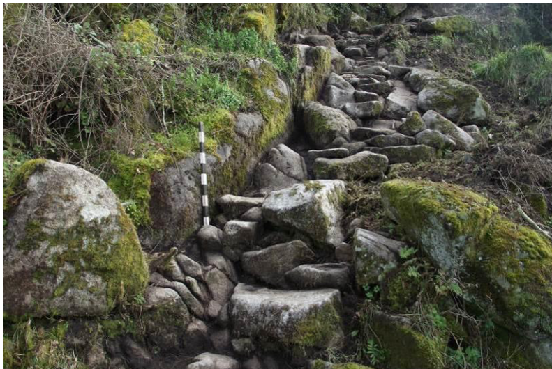
| SET – Troço da escadaria de pedra (OP 208) após limpeza.
