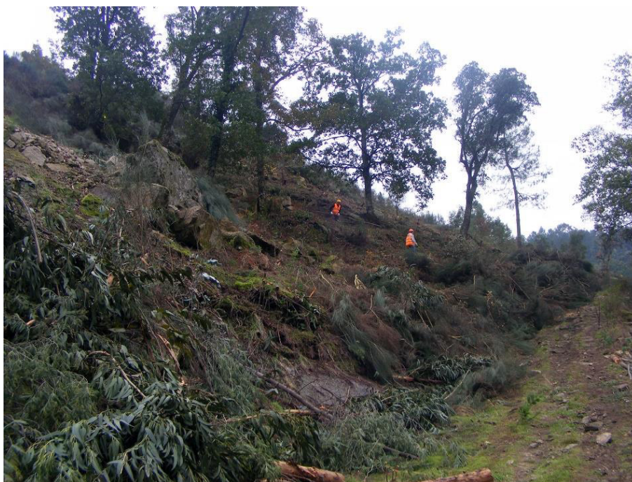
SET | Trabalhos de desmatção e limpeza na área afeta pela criação dos acessos provisórios (eixo 1)
