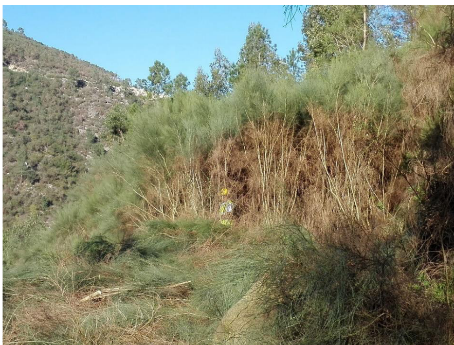
SET | Desenvolvimento de trabalhos de desmatção
