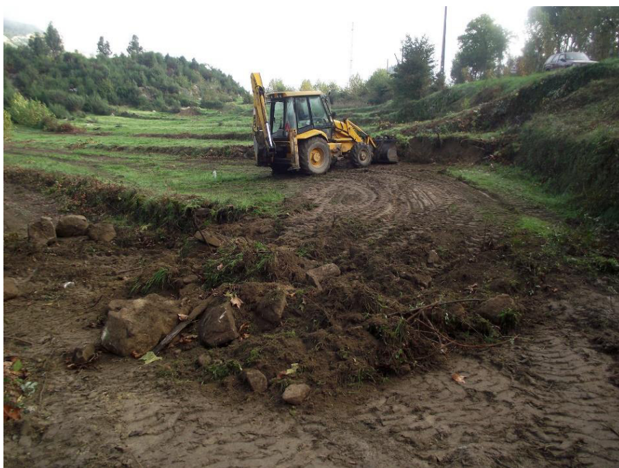
SET | Trabalhos inerentes à construção do estaleiro provisório da Conduril
