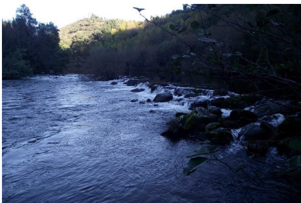
SET - Vista do açude, com a encosta prospetada em 2º Plano
