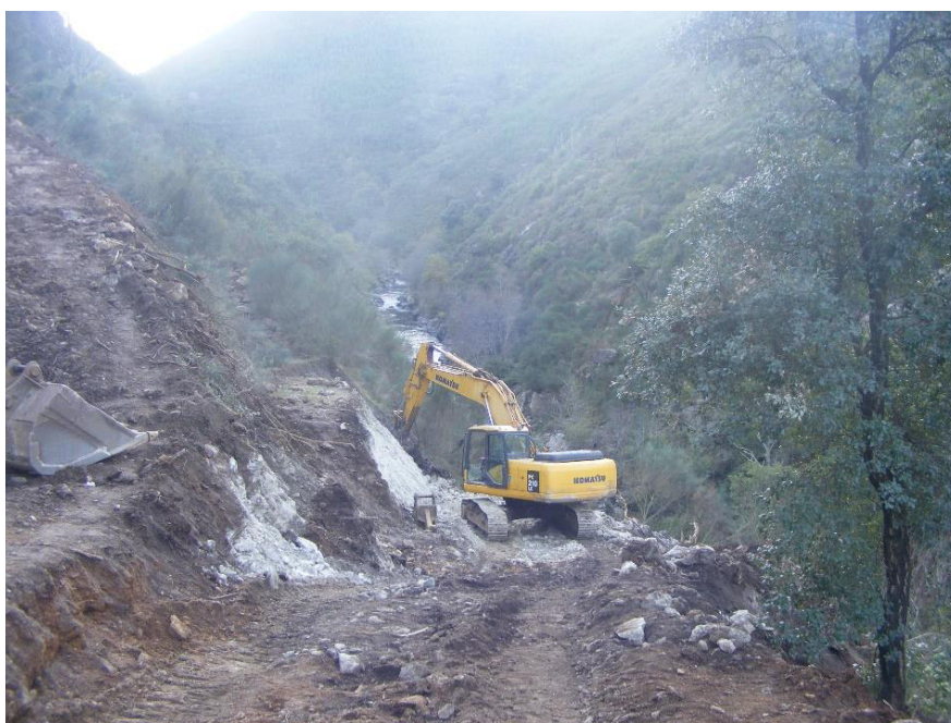
SET | Vista geral dos trabalhos de abertura do acesso (3ª galeria).
