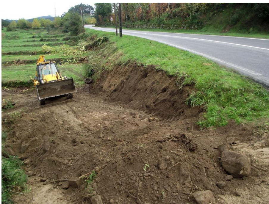
SET | Revolvimento de terras para preparação de acesso
