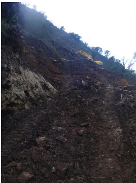
SET | Vista geral dos trabalhos de execução do acesso (2ª galeria).
