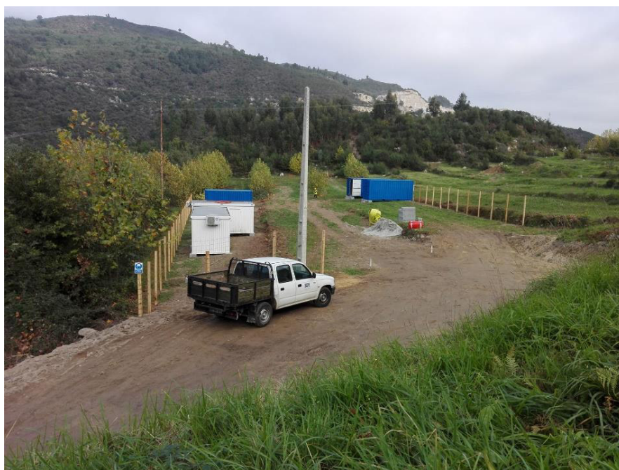
SET | Observação do espaço onde decorrem os trabalhos para construção do estaleiro da Conduril
