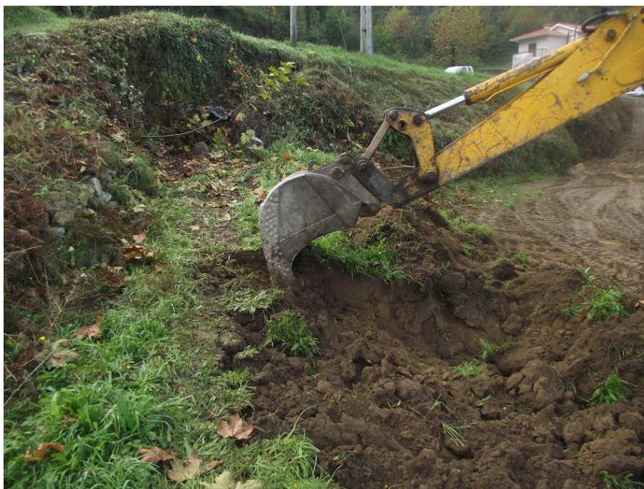
SET | Removimento de terras no âmbito da criação do estaleiro provisório da Conduril.
