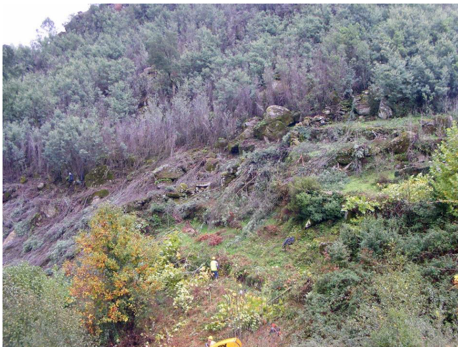
SET | Desmatação na área da albufeira
