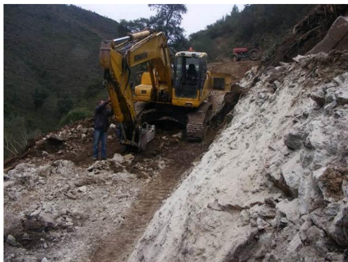
| SET – Criação de acesso à plataforma da galeria A.
