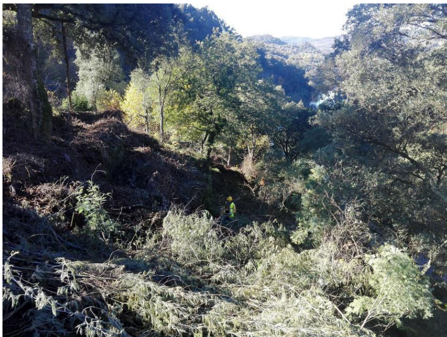
SET | Desmatação e limpeza na área onde se criará o acesso provisório (eixo 2)
