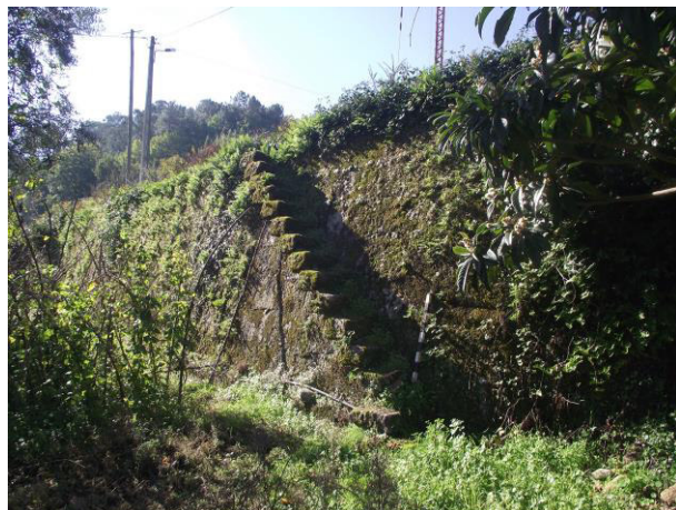
SET - Observação da Ocorrência Patrimonial n.º 210, a partir de norte
