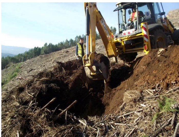
| SET – Abertura de poços de reconhecimento geológico na Subestação de Gouvães.
