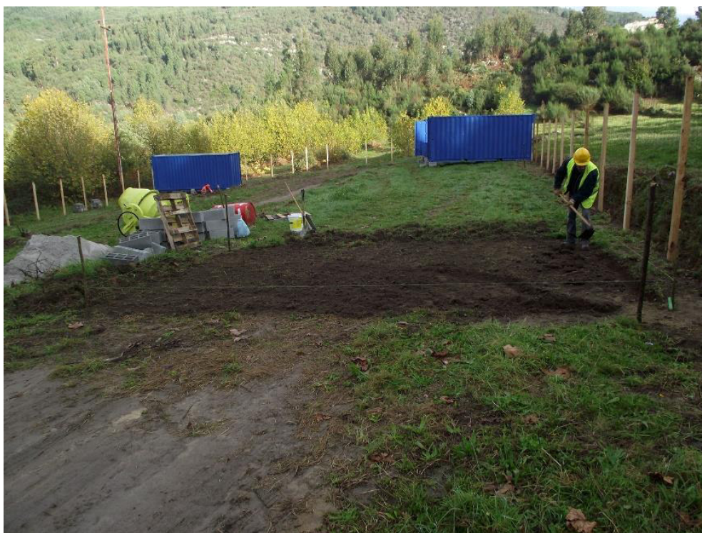
SET | Trabalhos para criação de depósito de gasóleo (Estaleiro da Conduril)
