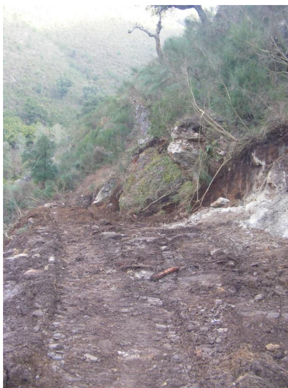
SET | Vista geral do acesso (2ª galeria).
