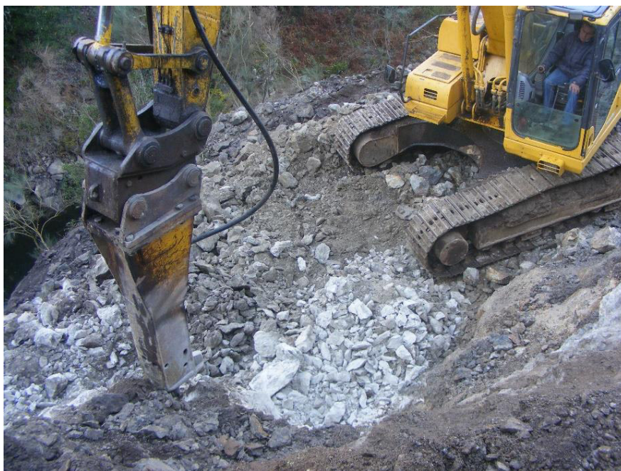
SET | Continuação dos trabalhos de abertura do acesso (3ª galeria).
