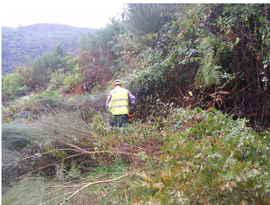
SET | Trabalho de desmatação na área do acesso provisório (eixo 1)
