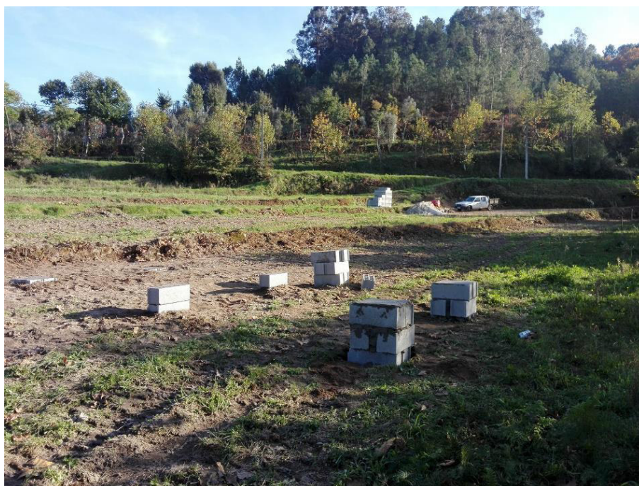
SET | Alicerces para colocação de contentores (estaleiro da Conduril)
