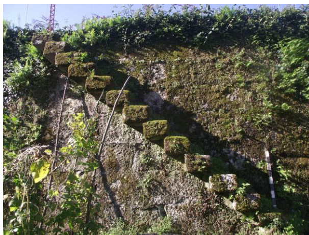
SET - Observação da Ocorrência Patrimonial n.º 210, a partir de norte
