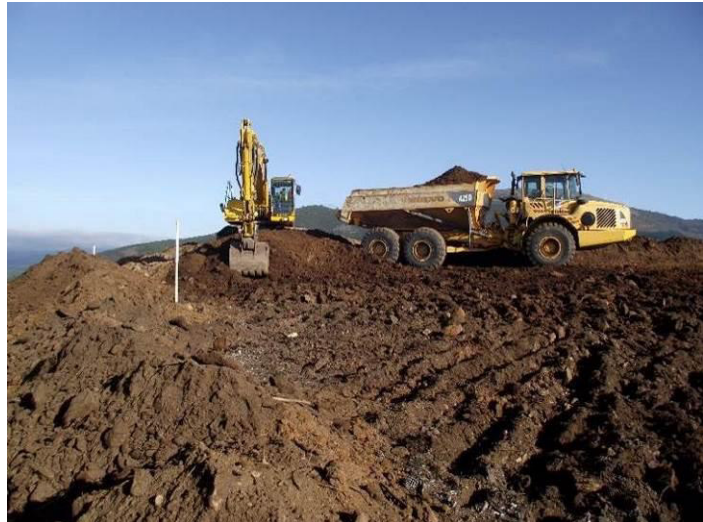
| SET – Decapagem de terras vegetais na plataforma da Subestação de Gouvães.
