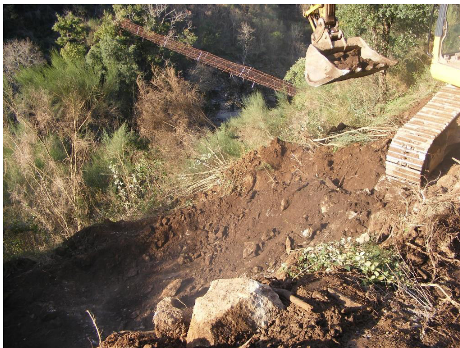
SET | Trabalhos de abertura de acesso (3ª galeria).
