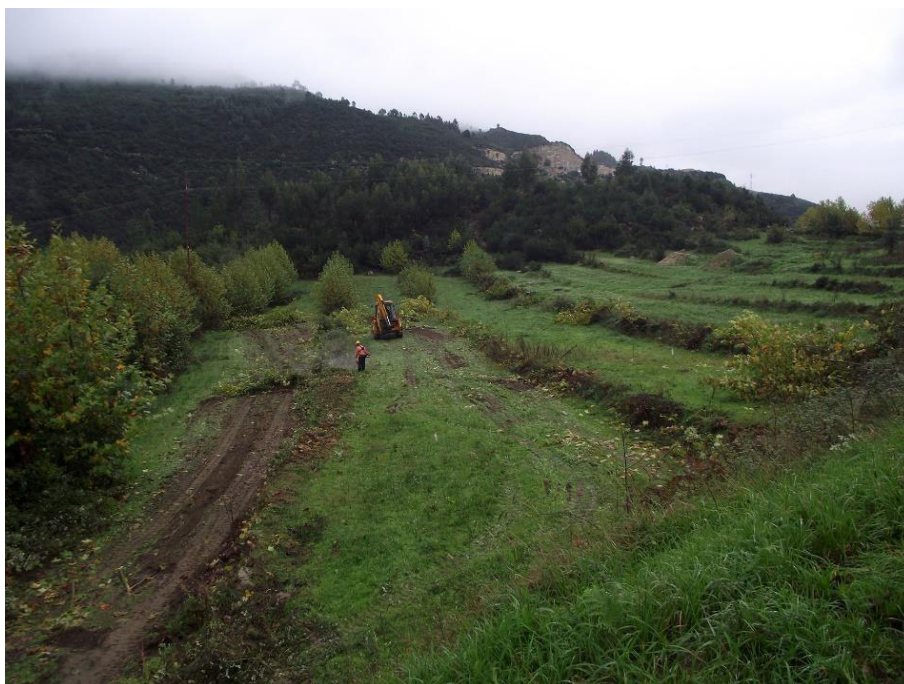
SET | Inícios dos trabalhos inerentes à construção do estaleiro da Conduril
