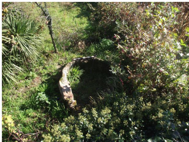
SET - Vista geral da OP 209, a partir da Estrada Nacional
