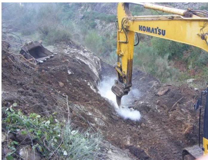
| SET – Acesso em construção para a galeria B do Alto Tâmega.
