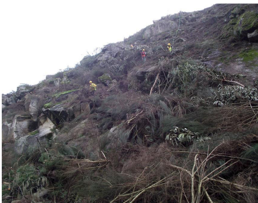
SET | Desmatação na área afeta pela construção do acesso provisório (eixo 1)
