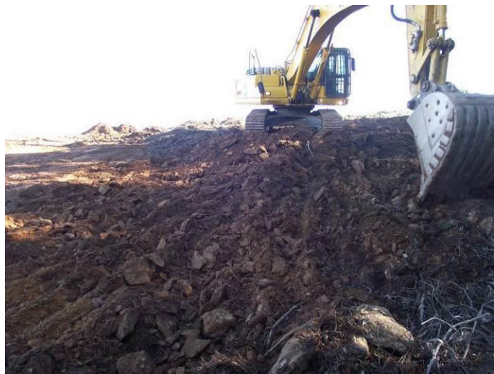
| SET – Decapagem na área da Subestação de Gouvães.
