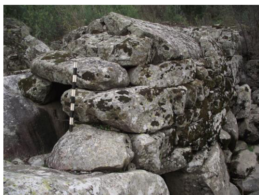
SET - Pormenor da entrada e paramento voltado ao rio
