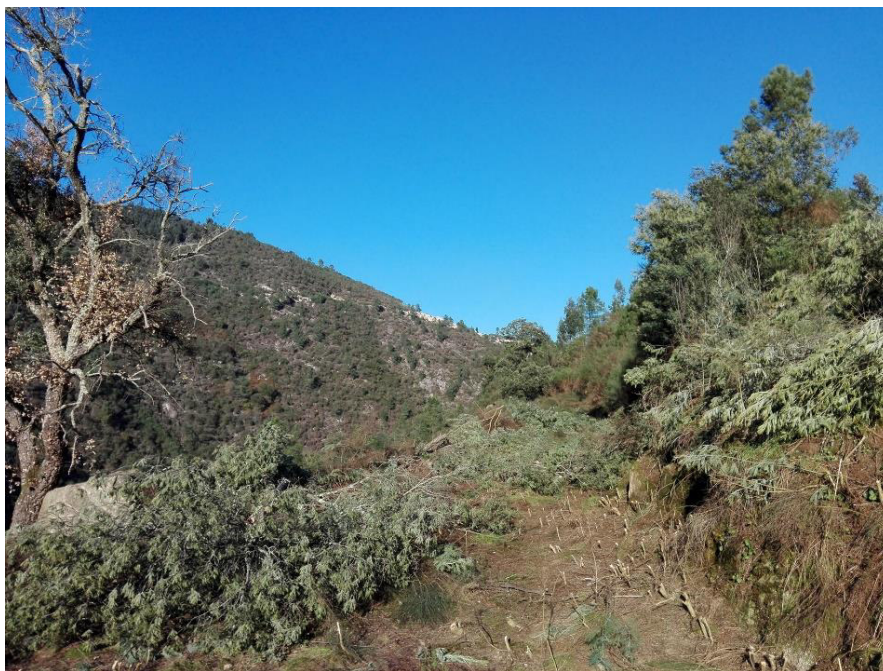
SET | Desenvolvimento de trabalhos de desmatção, para abertura acesso provisório (eixo 1)
