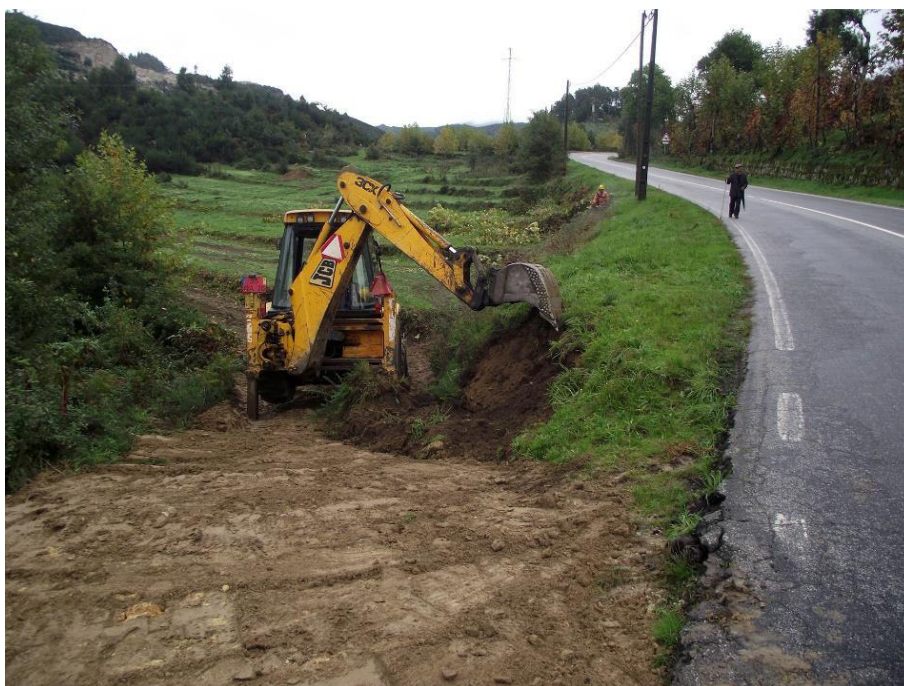
SET | Preparação de acesso ao futuro estaleiro da Conduril
