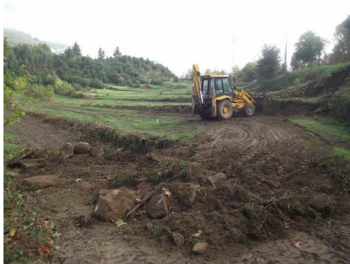
| SET – Preparação do terreno para implantação do futuro estaleiro.
