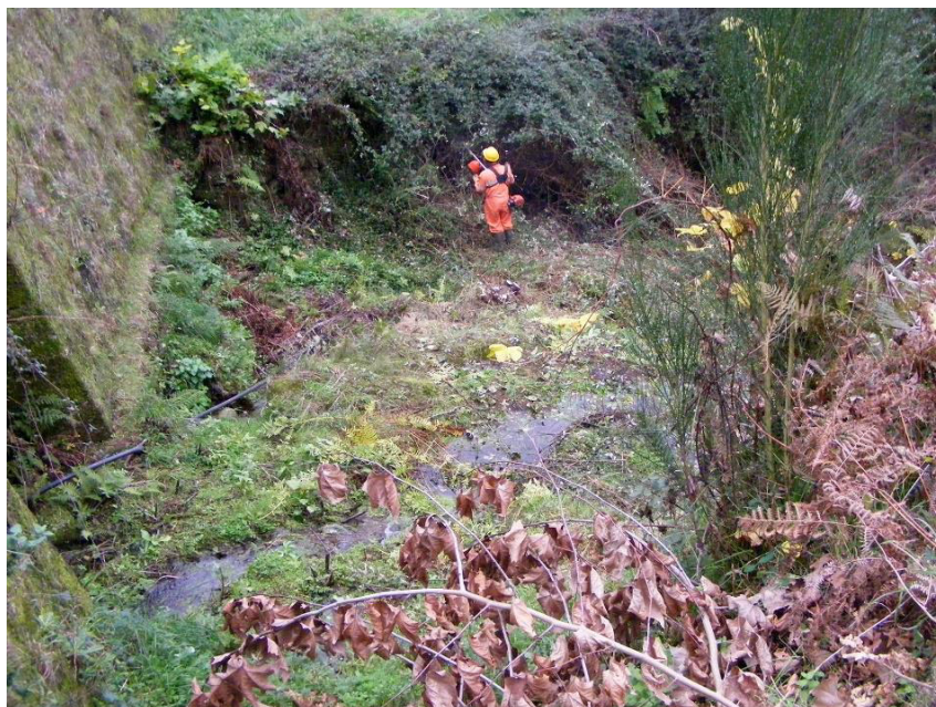
SET | Trabalhos de desmatção na ribeira da Fonte Fria.
