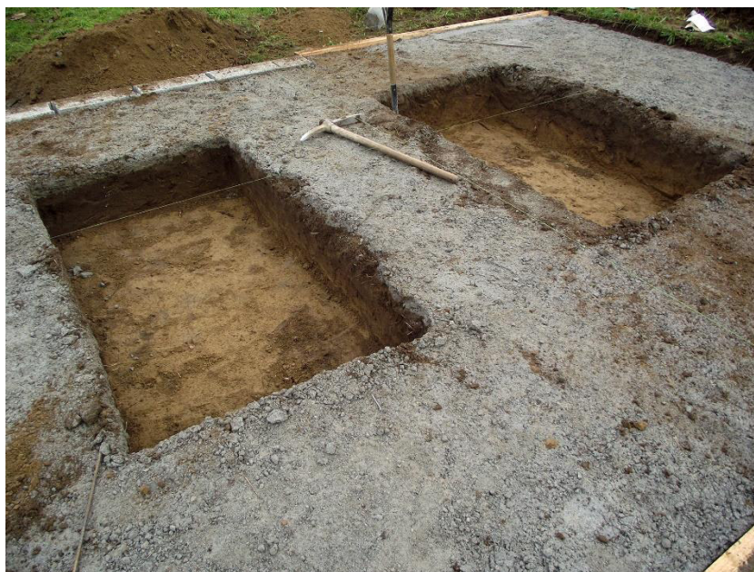
SET | Observação estratigráfica das valas abertas no âmbito de infraestrutura (depósito de gasóleo)
