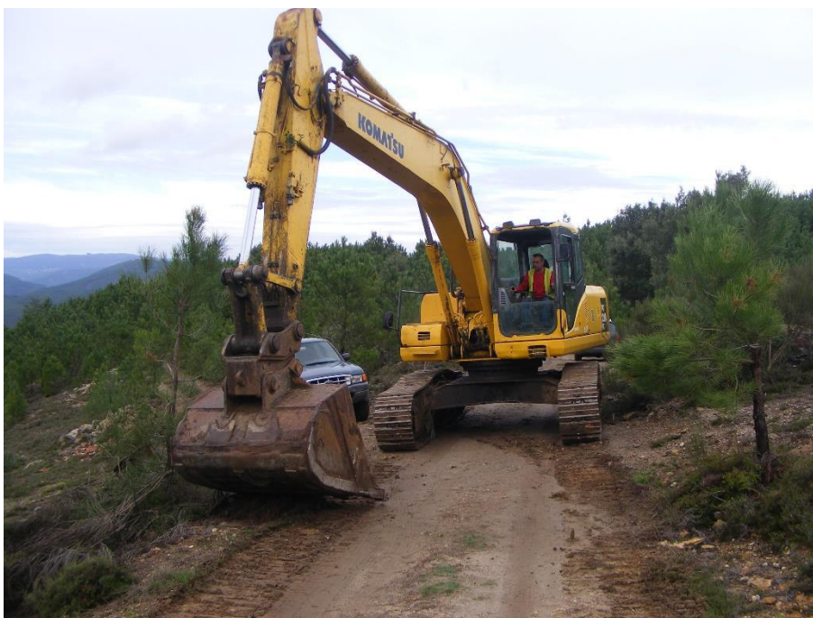
SET | Início dos trabalhos de retificação do estradão que liga a Parada de Monteiros.
