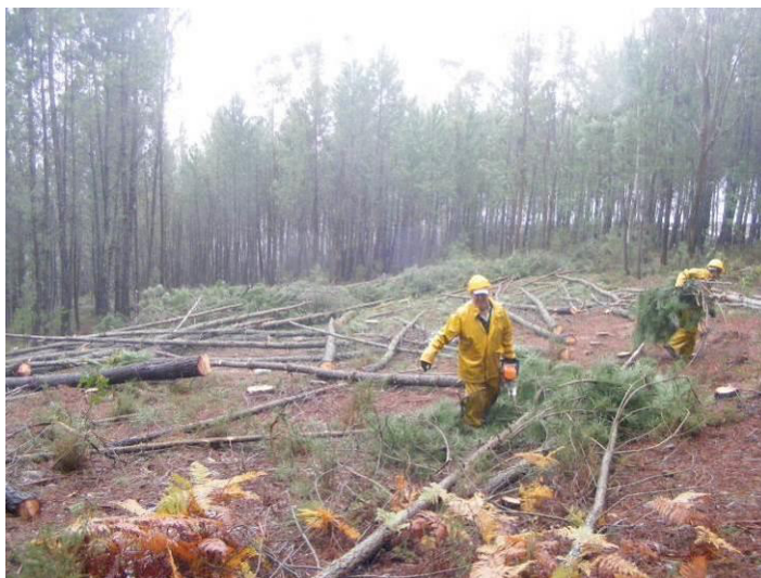
| SET – Desmatção em curso na Subestação de Gouvães
