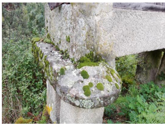
SET - Pormenor de base de sustentação da estrutura.
