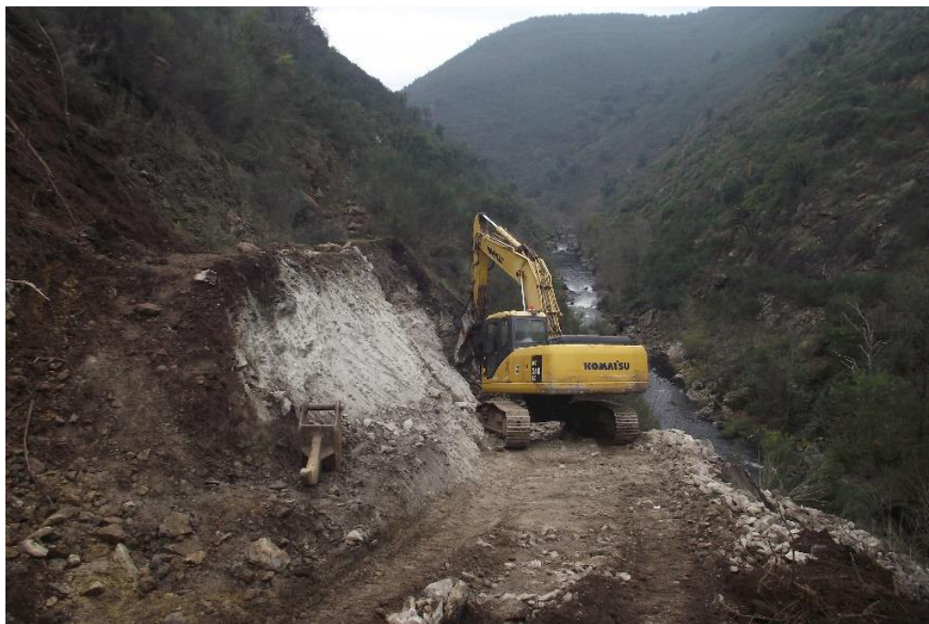
SET | Vista geral dos trabalhos de abertura do acesso (3ª galeria).
