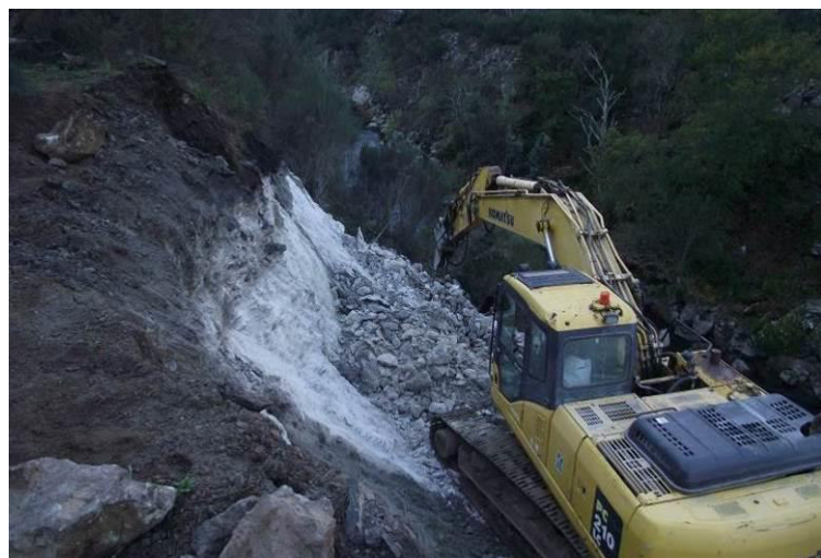
| SET – Acesso em construção para a galeria A do Alto Tâmega.
