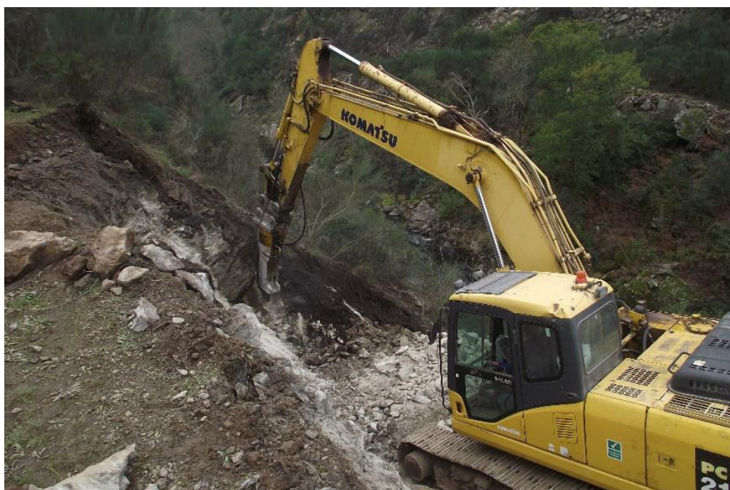
SET | Trabalhos de remoção do geológico para abertura de acesso (3ª galeria).
