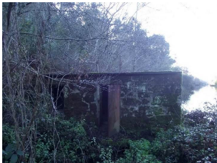
| SET – Moinho da Qtª do Terrão 3 (OP 215), margem esquerda do Tâmega, a jusante da futura barragem.
