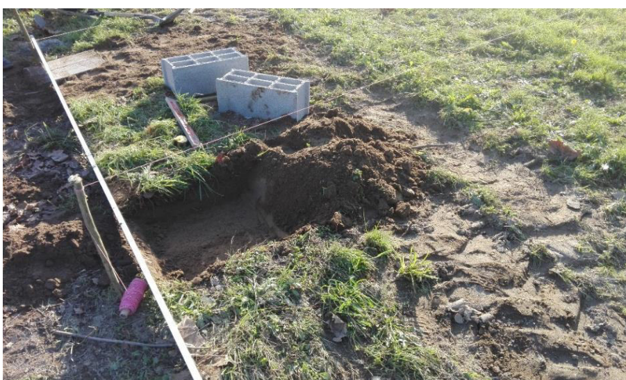
SET | Valas para implantação das bases dos contentores
