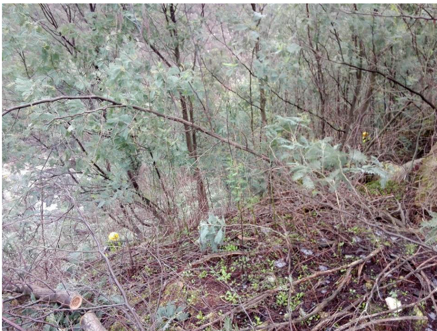
SET | Desenvolvimento de trabalhos de desmatção e limpeza (Eixos 1 e 2)
