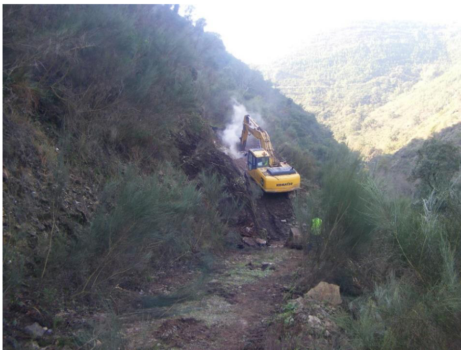
SET | Início dos trabalhos de abertura de acesso (2ª galeria).
