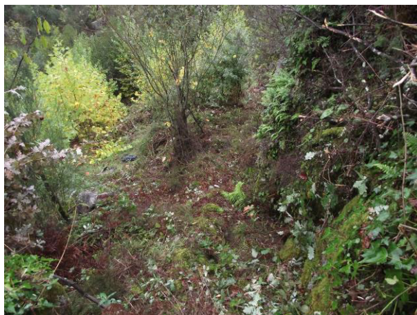
SET - Desenvolvimento da escadaria desde o morro onde se implanta a OP 196 até à ribeira. Vista a partir de sul
