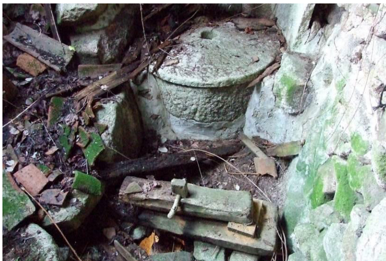
| SET – Pormenor do interior da OP 207.
