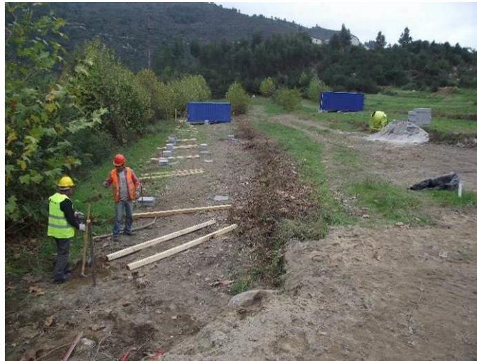
| SET – Montagem de estaleiro em Daivões.
