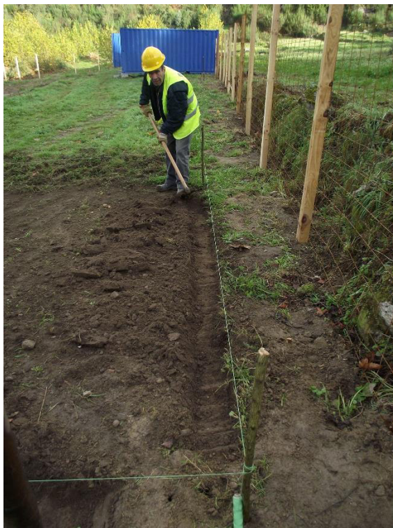
SET | trabalhos de escavação para criação de depósito de gasóleo
