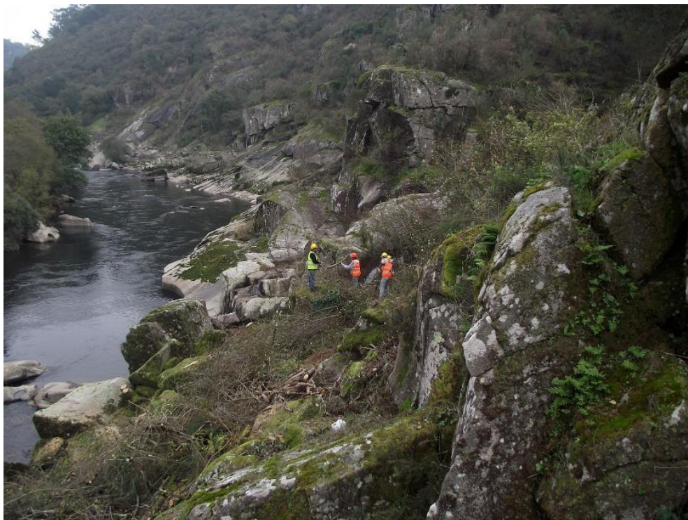
SET | Desmatção na área de enchimento da albufeira
