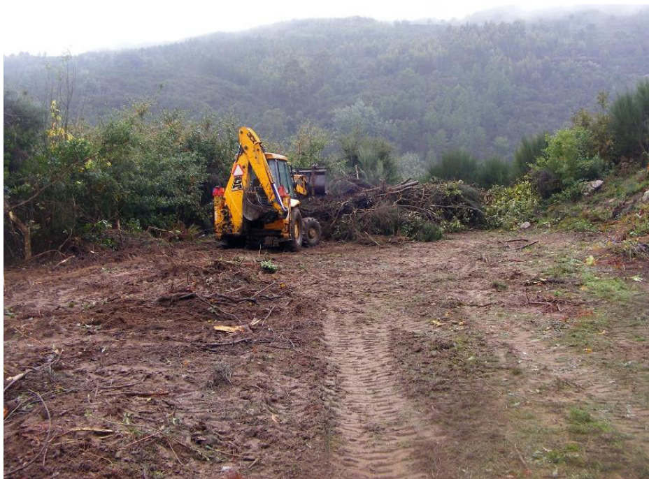
SET | Trabalhos de desmatção na área afeta pela construção do acesso provisório (eixo 1)
