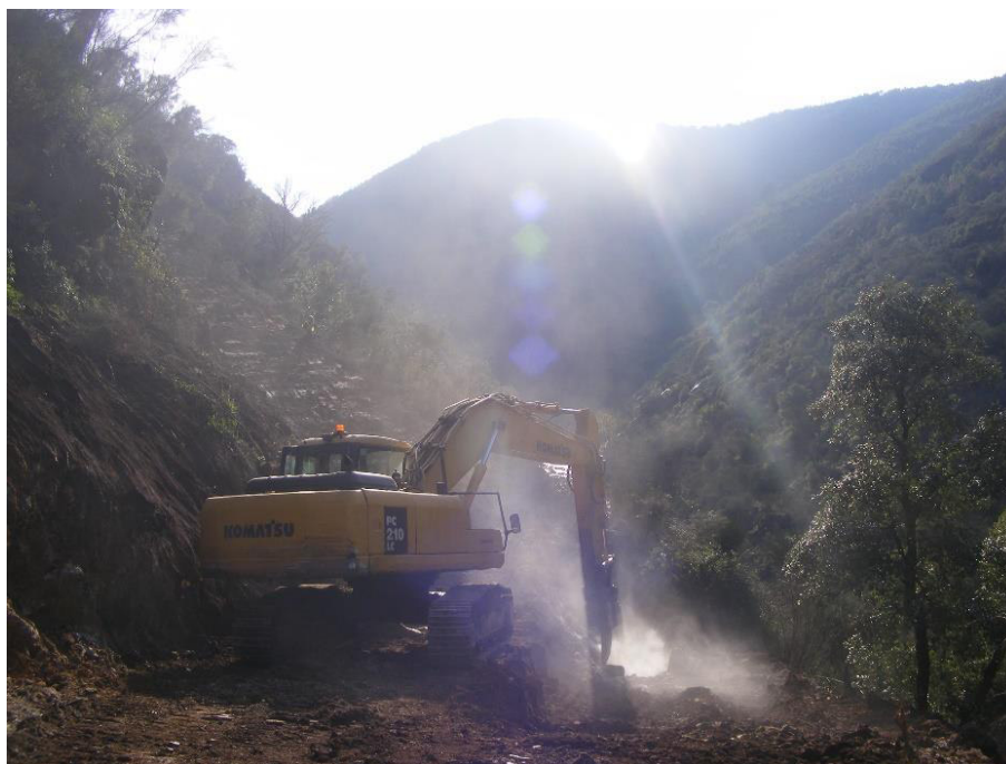
SET | Início dos trabalhos de abertura do acesso (3ª galeria).
